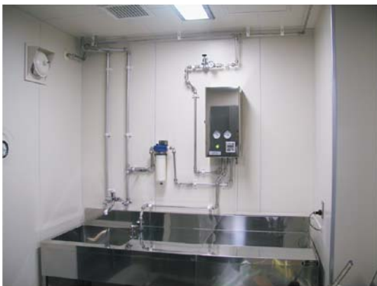
前室等の流し台へ設置
